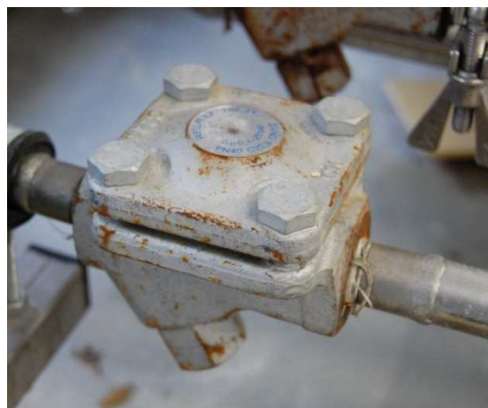
17. kép Kondenzvíz leválasztó szelep
