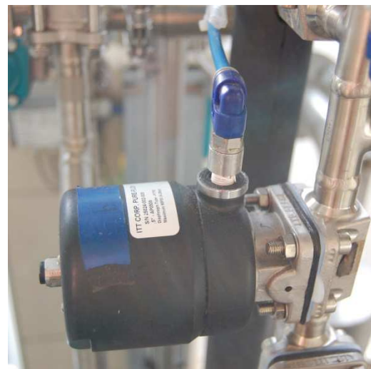
13. kép Pneumatikus membránszelep
